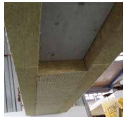
Betonipalkin alapinnan eriste kiinnitetään paloruuveilla.
