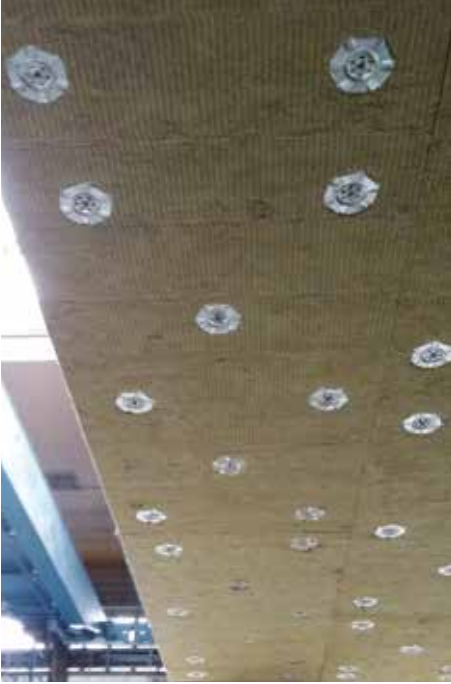
Palosuojattu betonilaatta.
